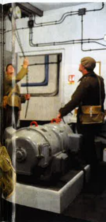
Dans « l'usine », un électromécanicien du 2 e Génie répare une fuite sur le circuit de refroidissement du groupe électrogène principal, un tri-cylindre diesel toujours en état de marche ! Ici c'est l'odeur de l'époque : huile et gazole ! Au fond, deux de ses camarades s'appêtent à remplacer une génératrice, tout l'outillage est d'époque et fonctionnel.
